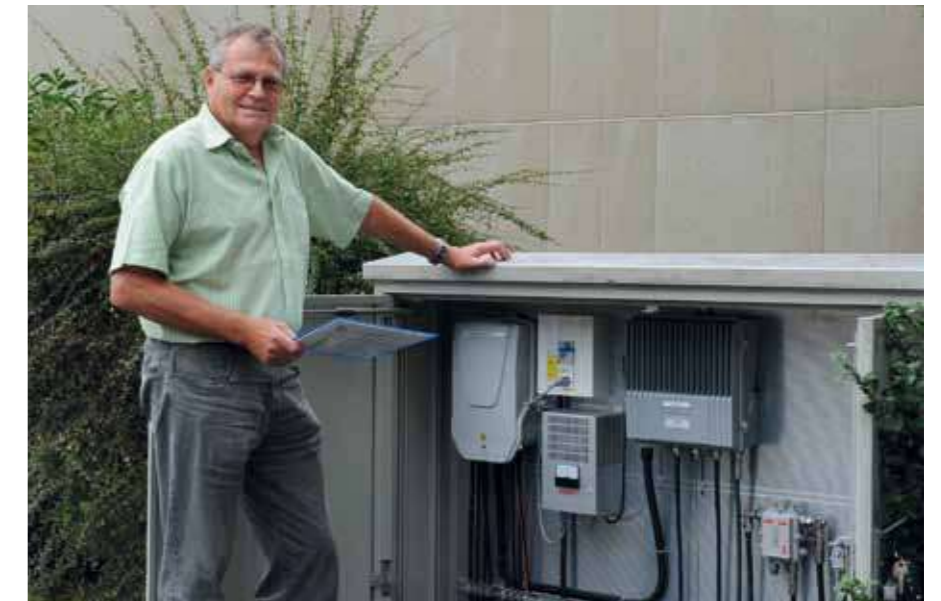
Roland Beck, Leiter Technik der GAG Grenchen, kontrolliert die laufenden Arbeiten
